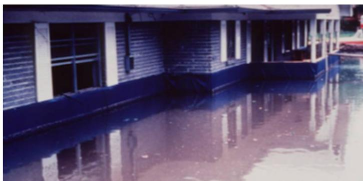
**Figura 10:** esempio di impermeabilizzazione con applicazione di una membrana di plastica
