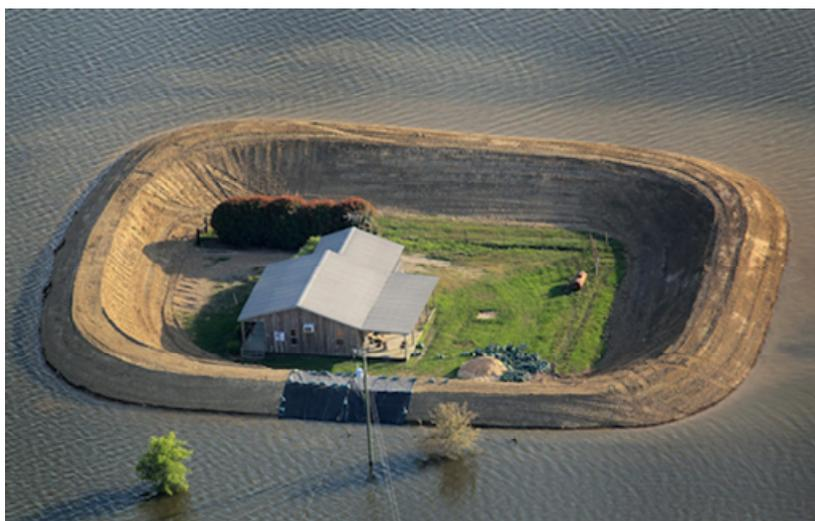
**Figura 4:** esempio estremo di protezione di una struttura mediante realizzazione di un argine
