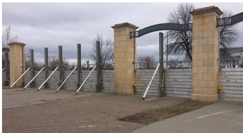
**Figura 5:** esempio di barriera anti-allagamento attuata con paratoie controventate
