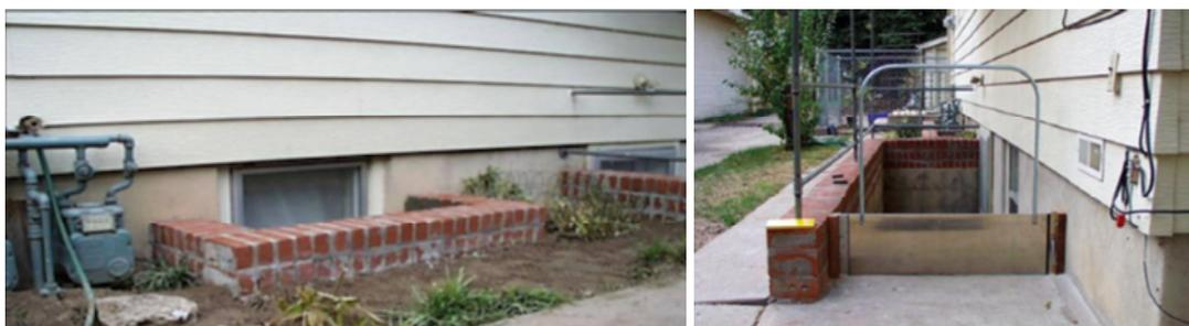
**Figura 11:** esempio di realizzazione di un muretto protettivo per una apertura di uno spazio seminterrato
