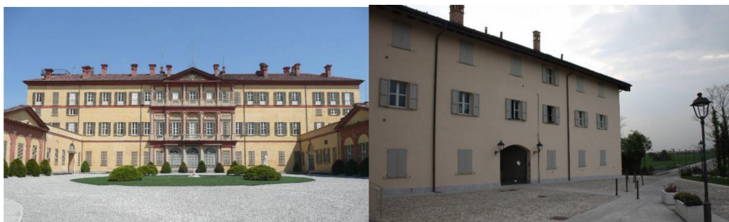
Villa Gallarati Scotti a Oreno e il complesso rurale di Camuzzago a Bellusco
