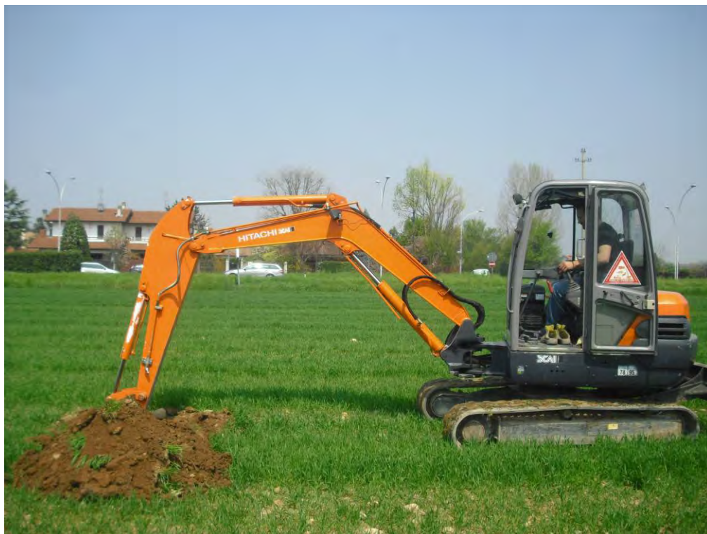
Esecuzione delle trincee.
