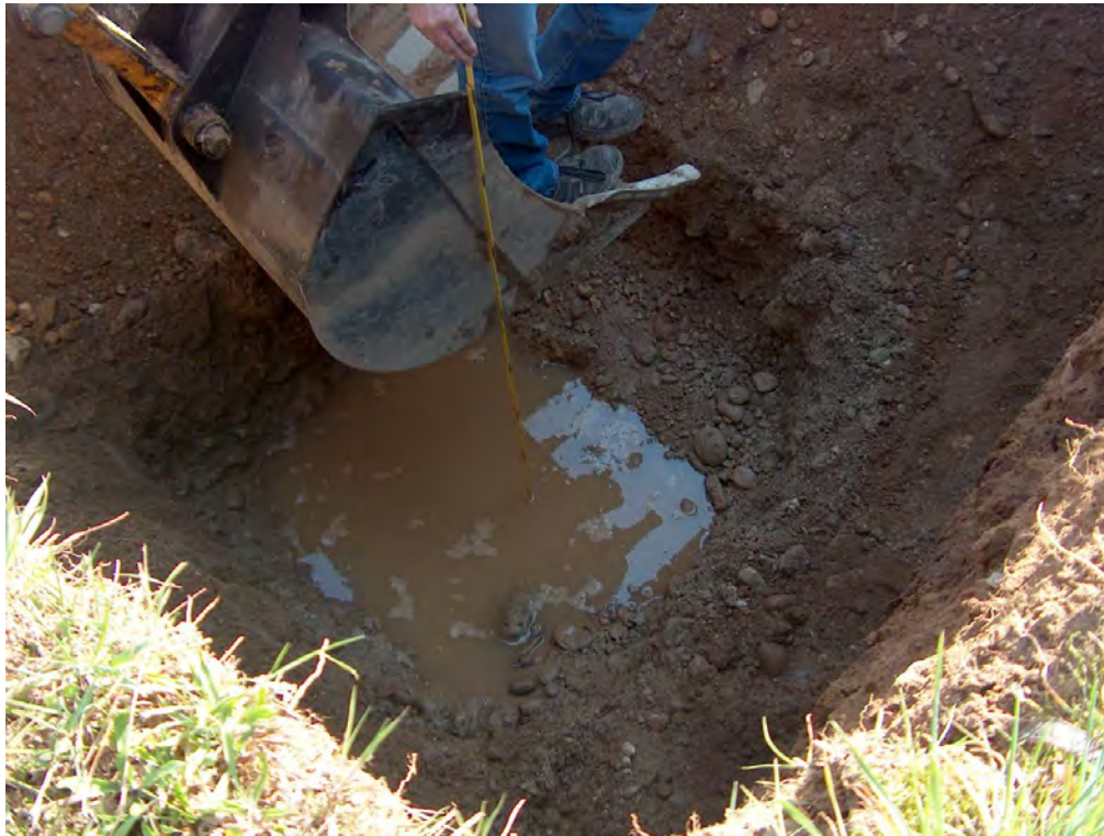
Esecuzione prova di infiltrazione.
