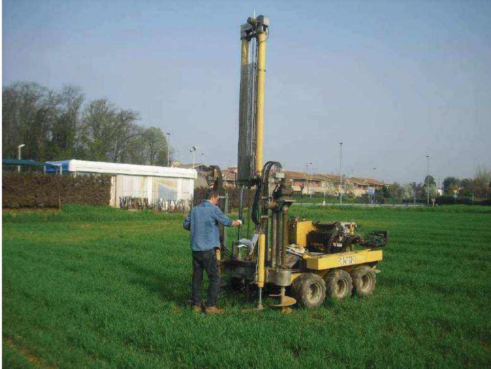
Esecuzione delle prove penetrometriche.
