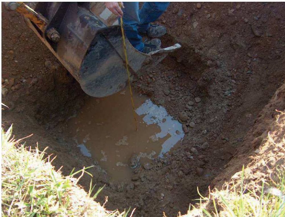
Esecuzione prova di infiltrazione.
