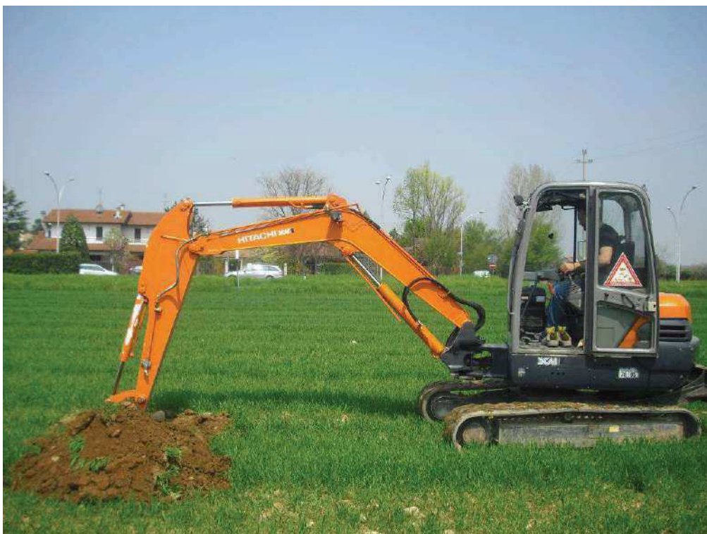
Esecuzione delle trincee esplorative.
